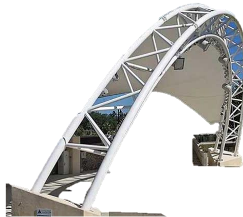
Gambar. 5 Atap Membran PTFE dan Struktur Pipa Baja Galvanis
