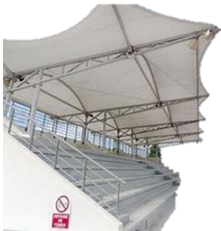
Gambar. 5 Atap Membran PTFE dan Struktur Pipa Baja Galvanis
